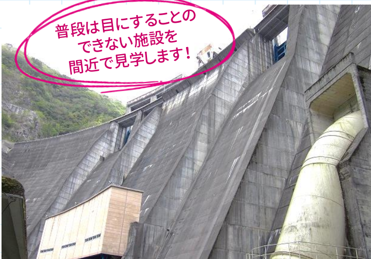
新阿武川発電所
